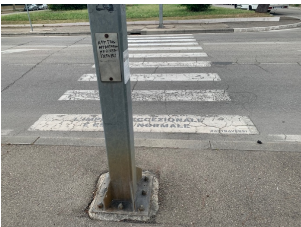
Attraversamento V.le Aldo Moro
