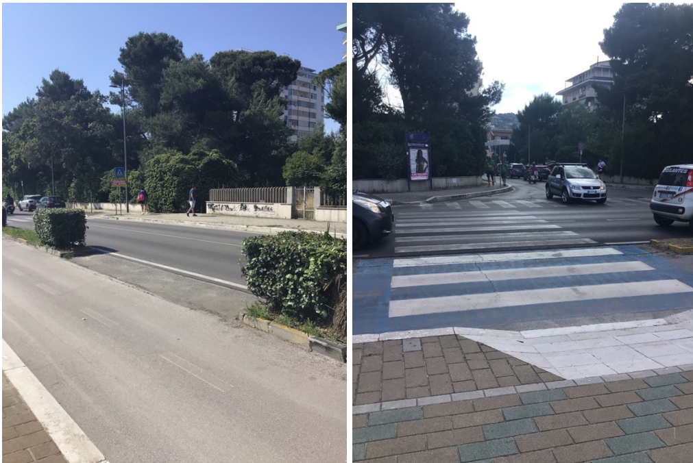
V.le Aldo Moro - varchi non corrispondenti ad accessi alla spiaggia - interruzione separazione fra pista ciclabile e sede viaria
